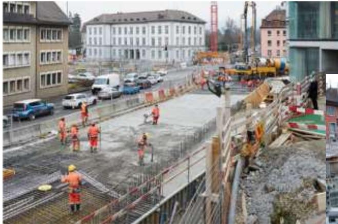
Die obere Fahrbahn wurde erneuert, was gleichzeitig das Dach des Bustunnels ist.
